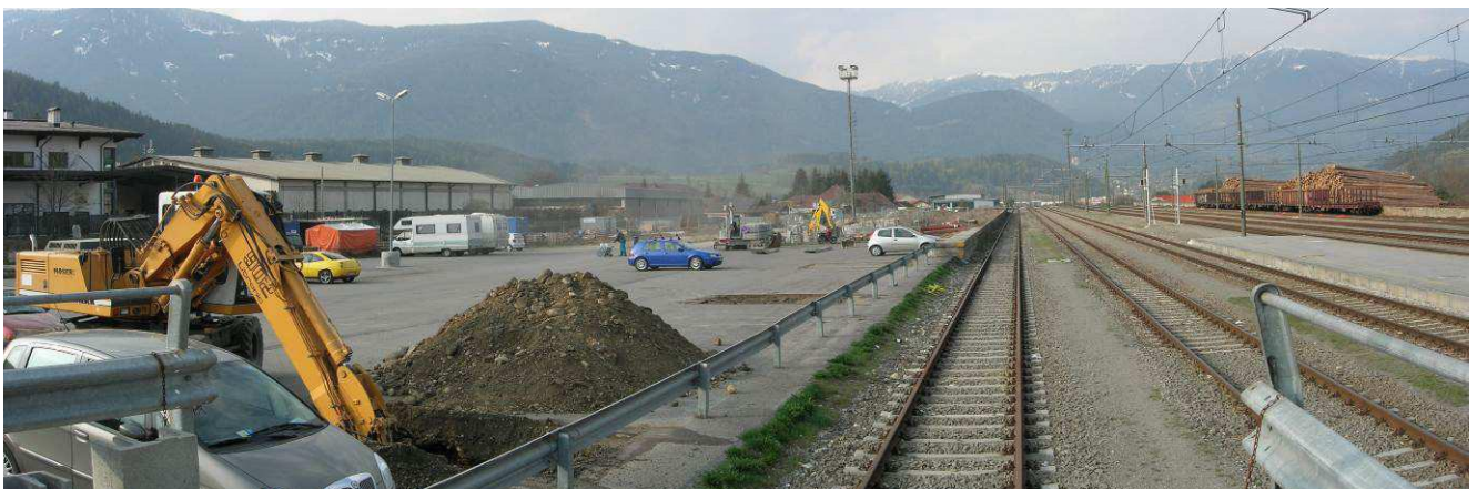
Foto 4: Aufnahme vom Areal südlich des bestehenden Bahnhofsgebäudes, am linken Bildrand sieht man Tieföffelbagger beim Aushub der Schürfgrube im Frühjahr 2007.
