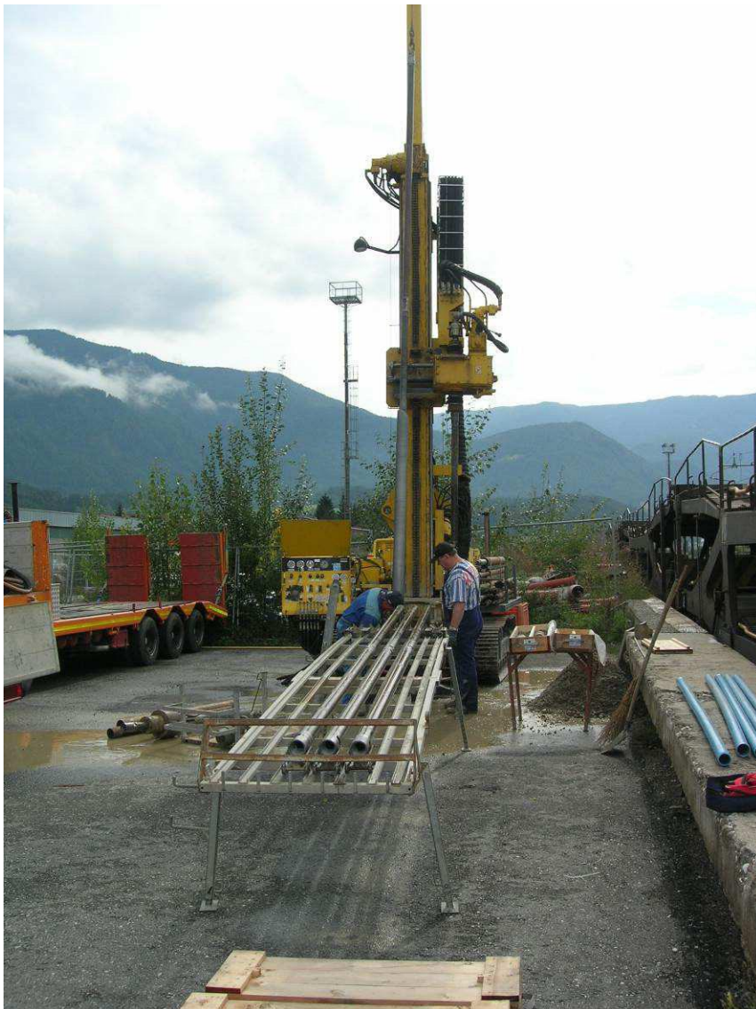
Foto 6: Ausführung Erkundungsbohrung B07/2 (Piezometer), Blick Richtung Südwesten. Esecuzione sondaggio geognostico B07/2 (piezometro), vista in direzione sudovest.
